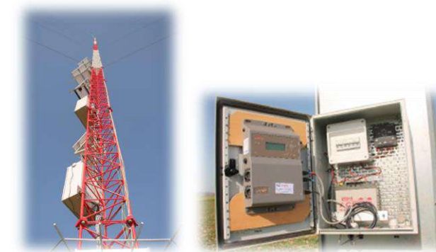
Figure 364: Installation du mât de mesure et du matériel d'enregistrement (SM3BAT) (Source : Étude d'impact écologique de NCA Environnement)
